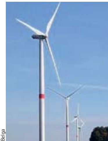
La plus haute en Wallonie Installée à Estinnes, l'éolienne Enercom E-126 mesure 198 m (132 m de mât) pour 6 à 7 MW.
