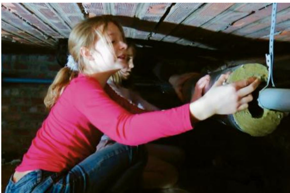
Les élèves apprennent à isoler les tuyaux de chauffage pour éviter que la chaleur ne se perde dans des endroits qui ne doivent pas être chauffés.
